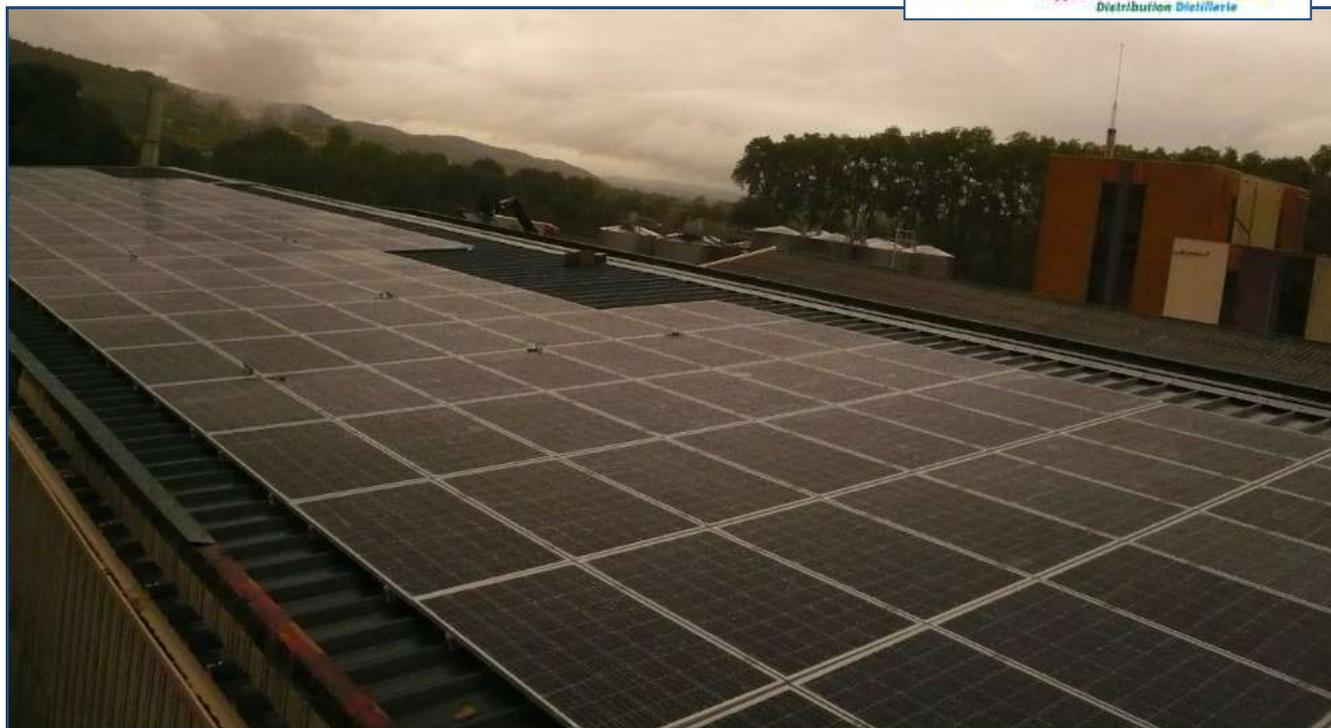
Puissance installée : 99,110 kWc, 374 modules SOLAR MODULE de 265Wc
